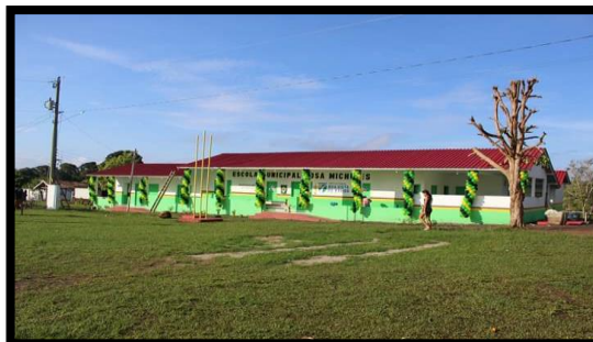
ESCOLA MUNICIPAL ROSA MICHILES REGIÃO: LAGO PRETO – ZONA RURAL ANO: 2019 – REFORMA E AMPLIAÇÃO
