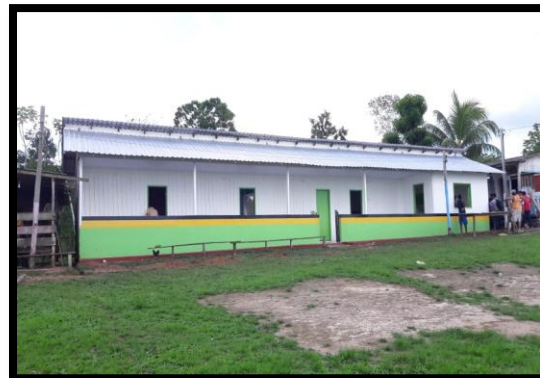
ESCOLA MUNICIPAL SOCORRO PEREIRA I REGIÃO: RAMOS DE CIMA – ZONA RURAL ANO: 2018 – REFORMA E AMPLIAÇÃO
