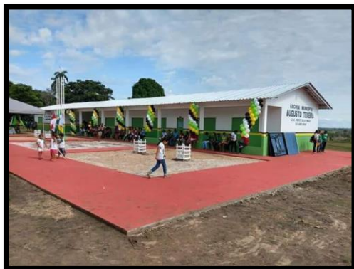
ESCOLA MUNICIPAL AUGUSTO TEIXEIRA REGIÃO: RAMOS DE BAIXO E LAGOS – ZONA RURAL ANO: 2018 – REFORMA E AMPLIAÇÃO
