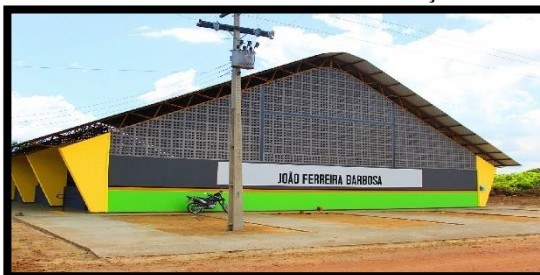
QUADRA POLIESPORTIVA JOÃO FERREIRA BARBOSA REGIÃO: RAMOS DE BAIXO E LAGOS – ZONA RURAL ANO: 2019 – CONSTRUÇÃO
