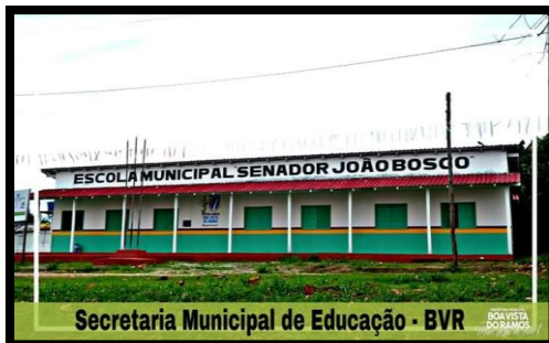
ESCOLA MUNICIPAL SENADOR JOÃO BOSCO REGIÃO: MASSAUARI – ZONA RURAL ANO: 2019 – REFORMA E AMPLIAÇÃO
