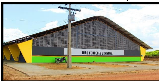
QUADRA POLIESPORTIVA JOÃO FERREIRA BARBOSA REGIÃO: RAMOS DE BAIXO E LAGOS – ZONA RURAL ANO: 2019 – CONSTRUÇÃO
